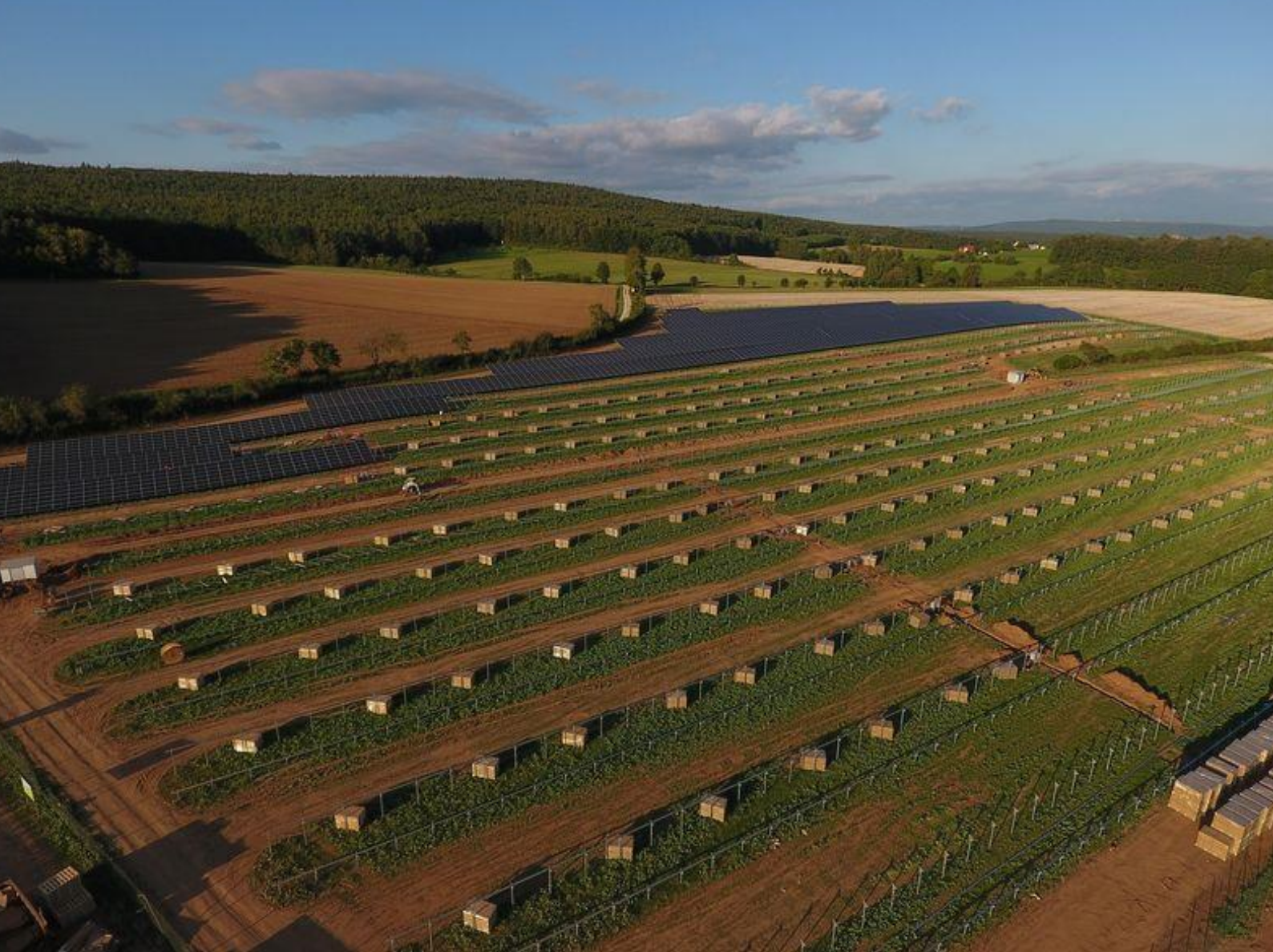
Bürgersonnenenergie Röbersdorf (Bauphase)
