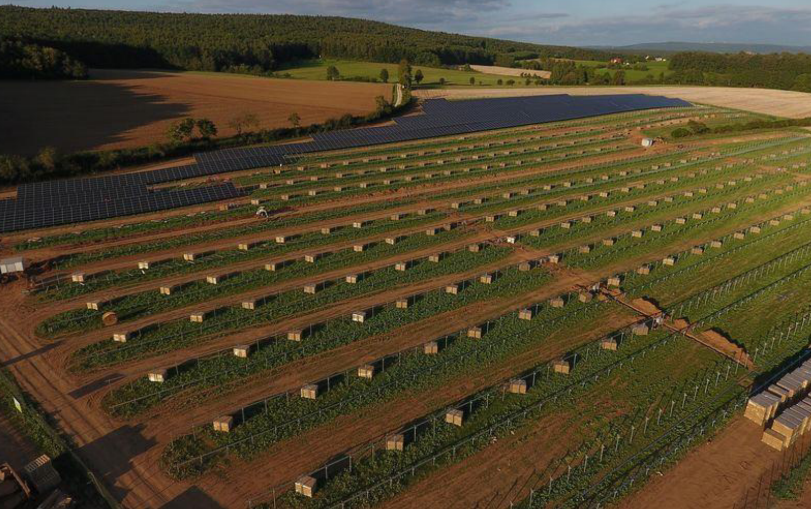
Bürgersonnenenergie Röbersdorf (Bauphase)
